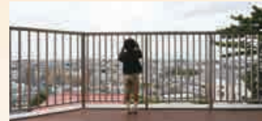
高さ約120cmの頑丈な柵を設置しています。
